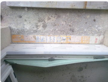
Toplotni most rešen s tipskim elementom, pogled od zgoraj po izdelavi balkonske plošče
