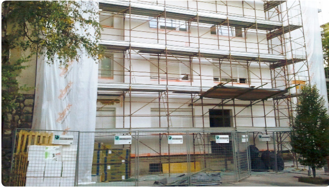
Energijska prenova večstanovanjske stavbe s kontaktno fasado
